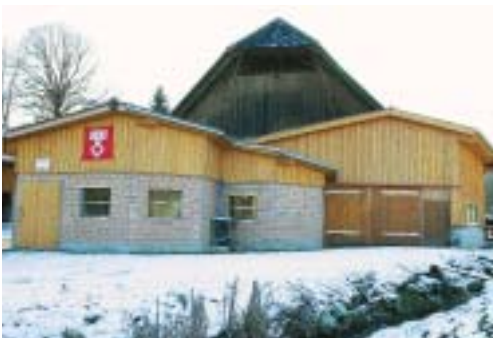
Gesamtansicht, wobei der Anbau im Vordergrund sehr gut zu erkennen ist.
