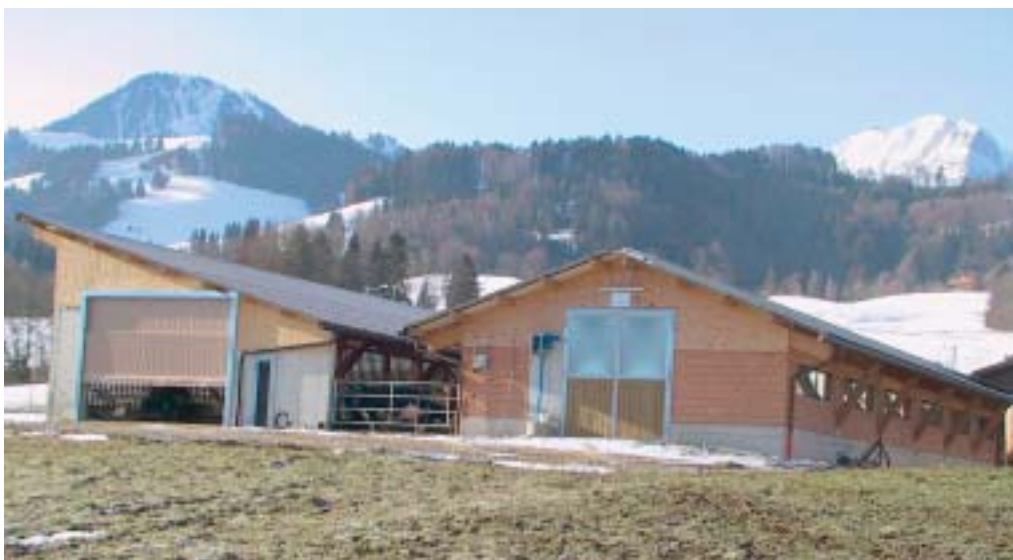
Gesamtansicht des Laufstalles für die Milchkühe mit Moléson im Hintergrund
